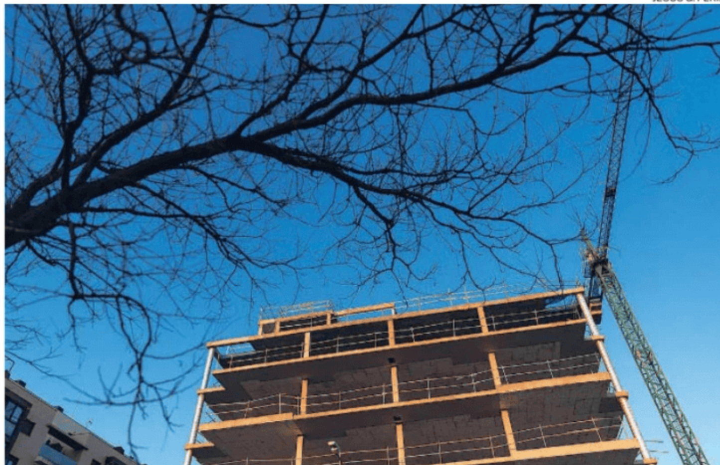
Una promoción de obra nueva en plena construcción en Madrid
